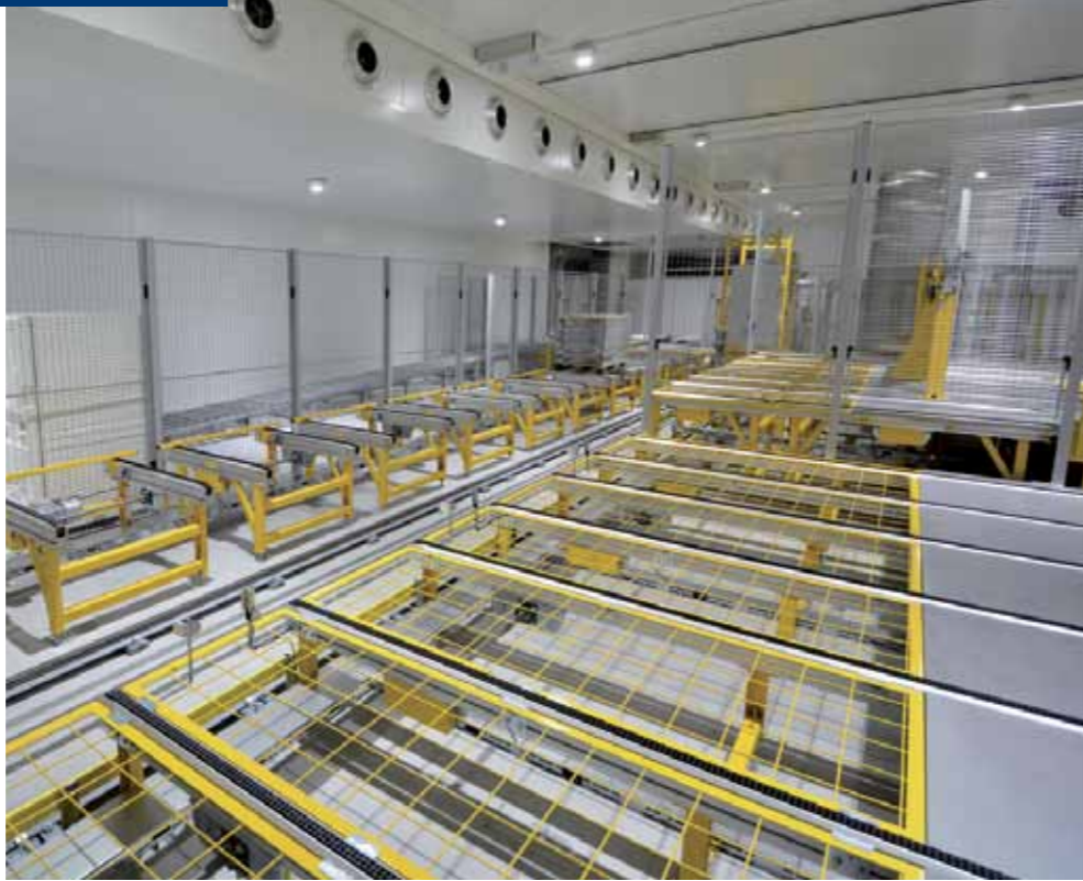
5 Im Bereich der Kommissionierung werden kundenspezifische Paletten zusammengestellt.
